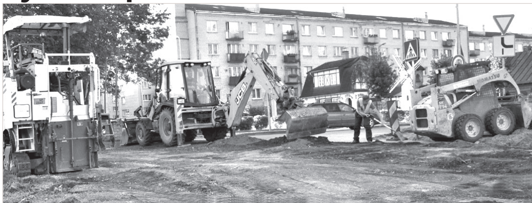
На улице Райня продолжаются ремонтные работы.
